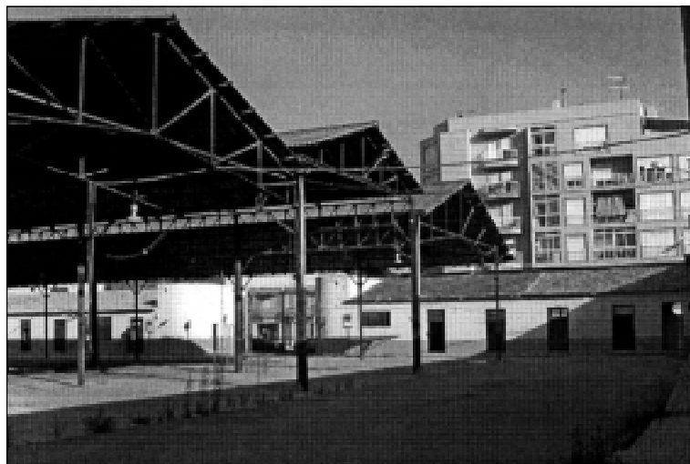
Fig. 7. Vista de les tres armadures encavallades metàl·liques de les naus amb l'accés sud al fons.
