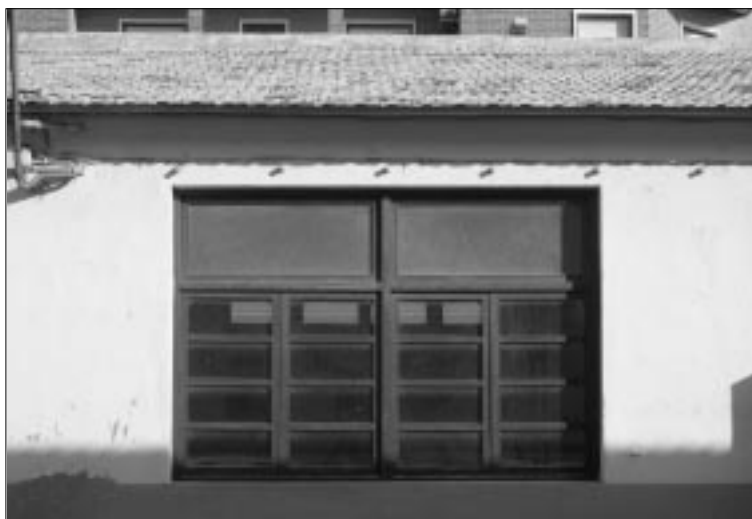
Fig. 11. Detall d'una de les finestres de fusta, amb espejament i probable color original
