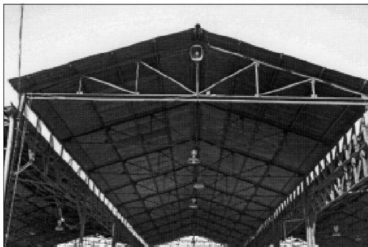
Fig. 12. Detall de la cobertura de la nau central d'estructura metàl·lica soldada executada el 1963.
